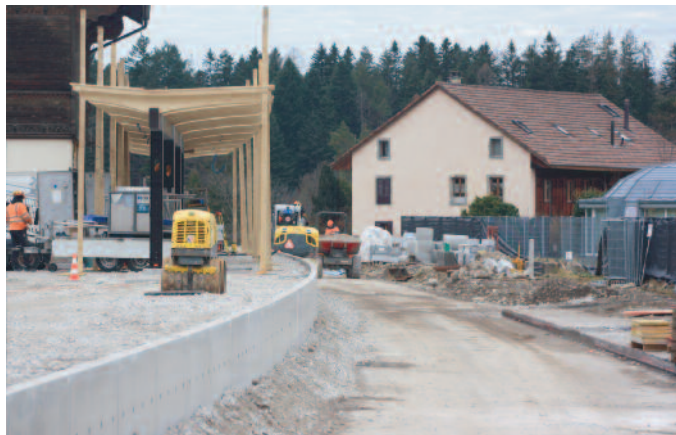
Gare de Broc-Village. Construction de la marquise sur le quai.
