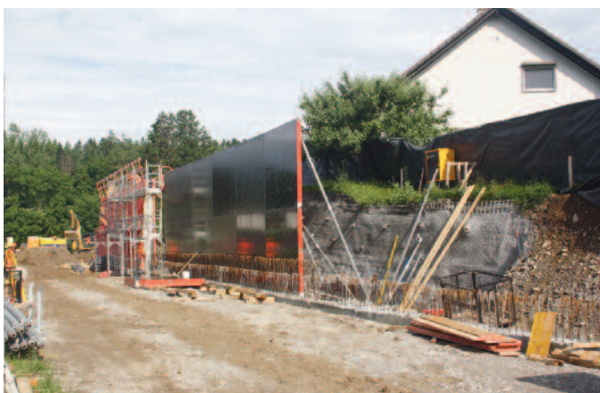
Tronçon Broc-Village - pont sur la Sarine. Etat des travaux du mur de soutènement.
