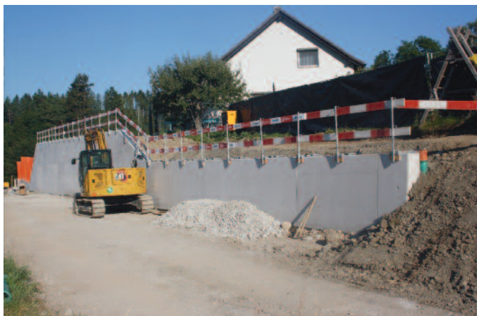
Broc-Village. Vers les villas du Clos du Carro. Etat des travaux de la ligne Bulle-Broc VN. Ici le mur de soutènement entre le pont sur la Sarine et Broc-village.
