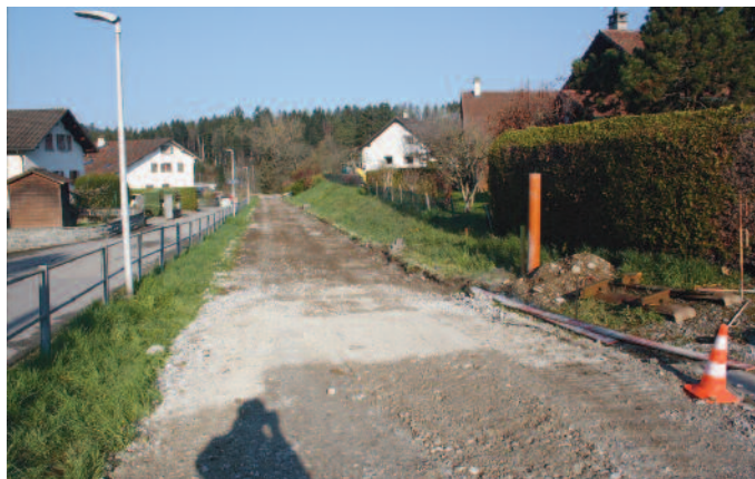
Broc-Village. L'ancienne plateforme de la voie Broc-Village - pont sur la Sarine dépourvue de ses rails.
