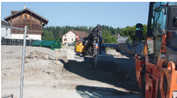
Broc-Village. En gare, travaux de terrassement pour la nouvelle voie.
