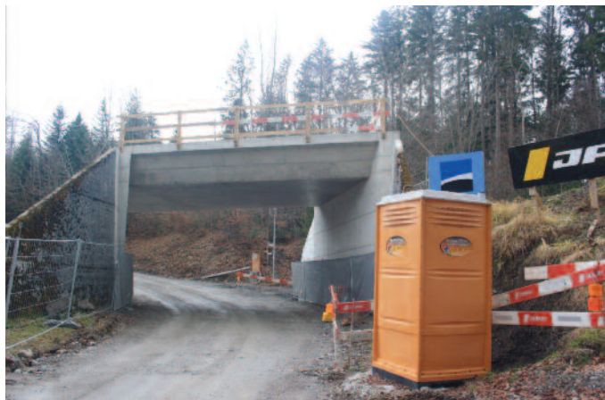
En Bouleyres. Ancienne halte des Marches. Le passage sous-voie pour le chemin de Bouleyres.
