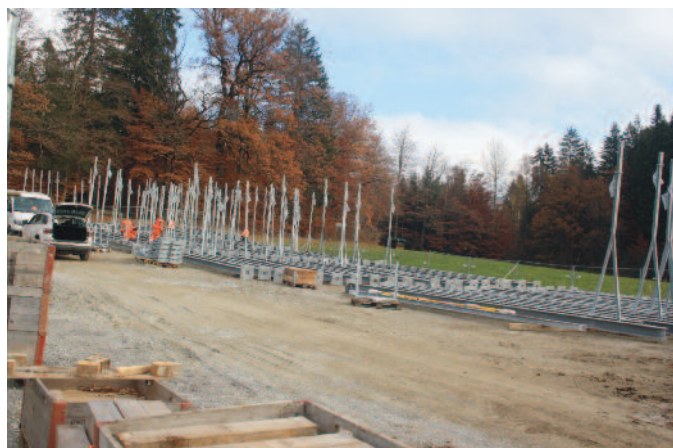
Pra-Bosson. Sur la place des travaux, on monte les bras sur les pylônes de la nouvelle caténaire.
