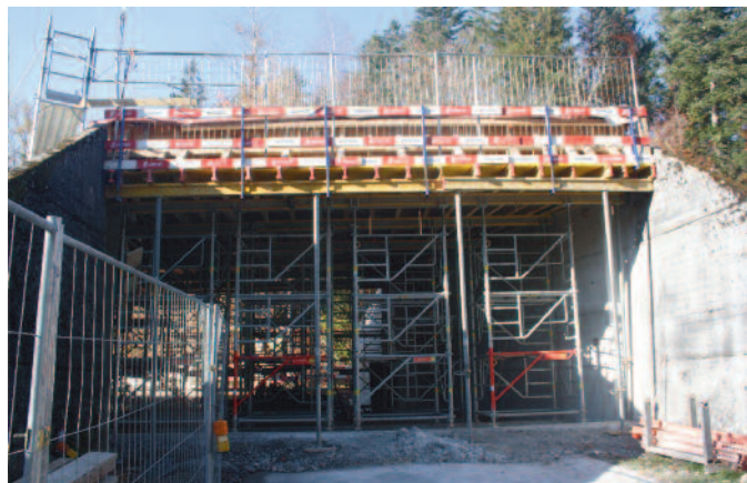
En Bouleyres. Construction du nouveau pont sur le chemin de Bouleyres à l'ancienne halte des Marches.
