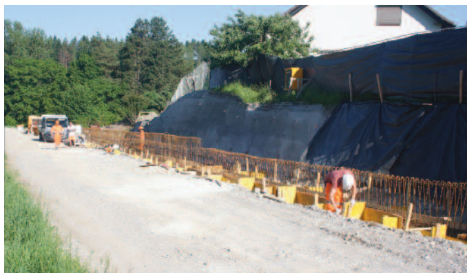
Broc-Village. Tronçon Broc-Village – pont sur la Sarine. Construction d'un mur de soutènement et de sécurité.
