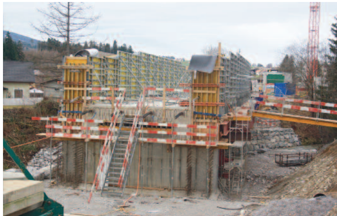
Pra-Bosson. Construction du pont sur la Trême vue du côté de Broc.
