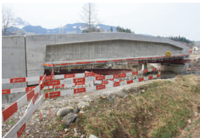
Pra-Bosson. Etat des travaux du pont sur la Trême.
