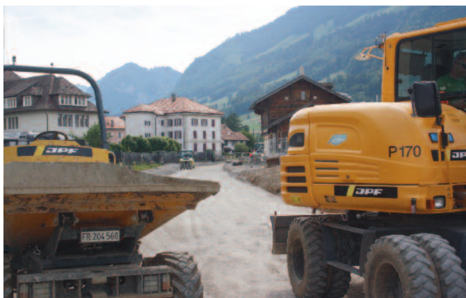
Etat des travaux de terrassement pour la nouvelle voie.
