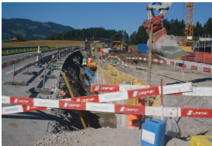
Etat des travaux de la ligne Bulle-Broc VN. Ici en Pra-Riond, préparation pour un passage sous-voies pour le bétail.
