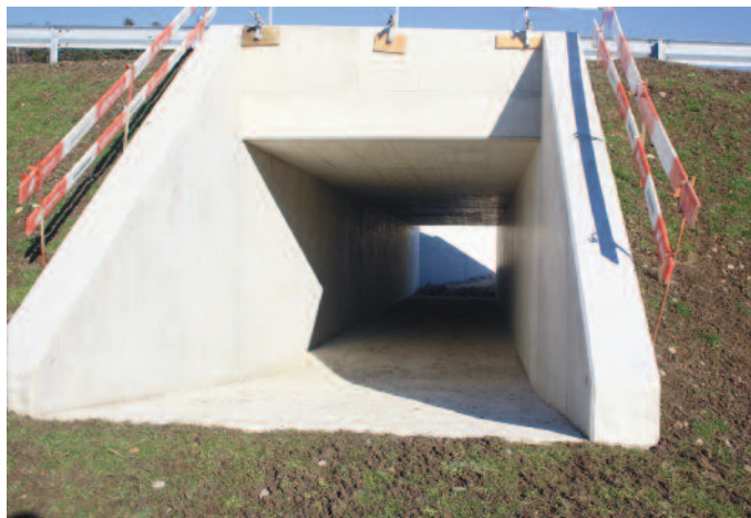
Pra-Riond. Passage sous-voies.
