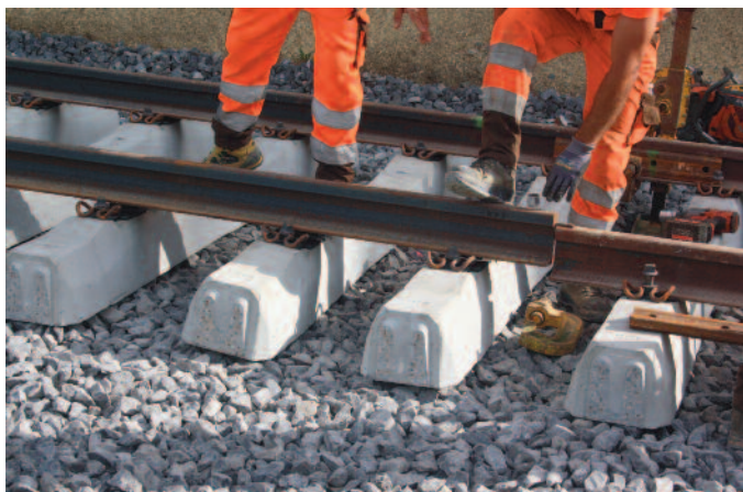
Pra-Bosson. On procède à la mise en place d'un rail d'une longueur de 36 m.
