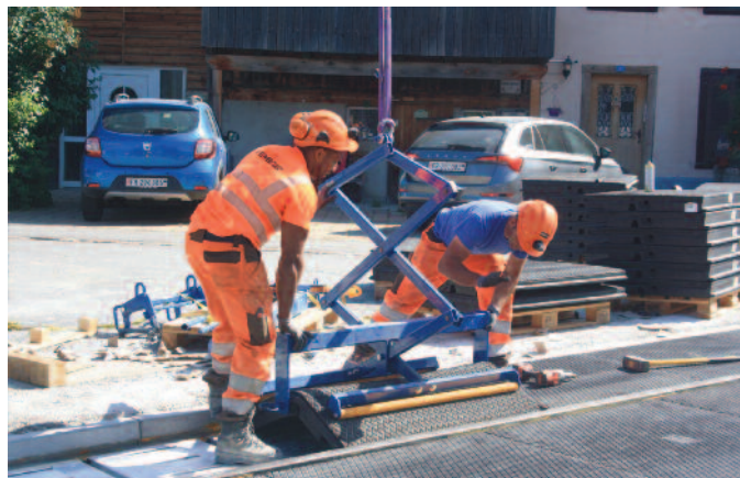
Broc-village. Pose des dalles au PM de la rue Cailler.
