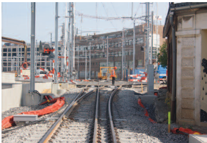
Bulle. Aiguillage de la voie à 3 rails. A droite la voie normale, à gauche la voie étroite.
