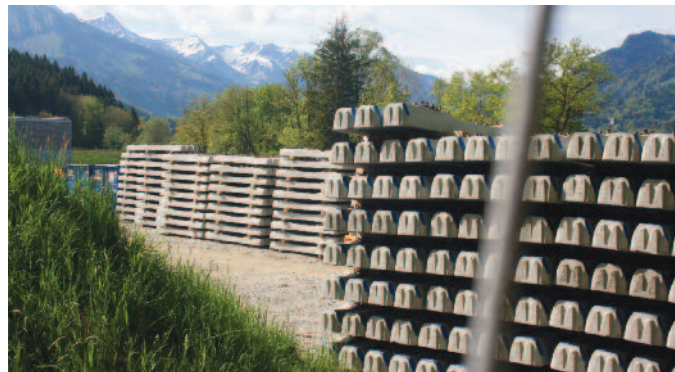
Pra-Bosson. Stockage des traverses en béton.
