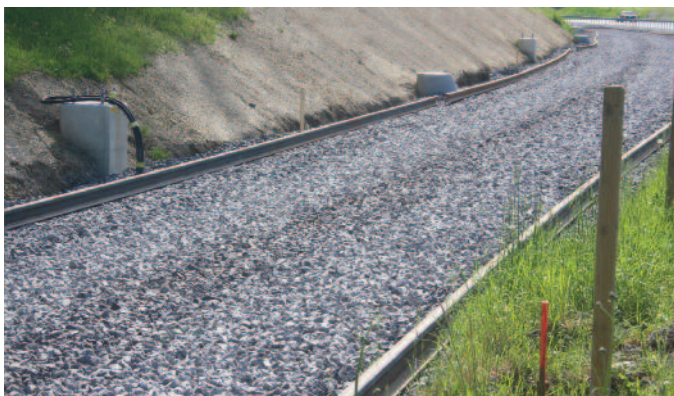
Pra-Bosson, direction Pra-Riond. Ballast et rails prêts pour la mise en place.
