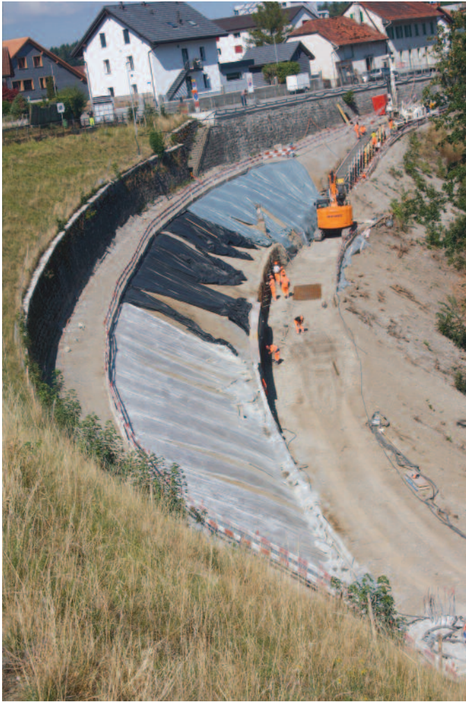
Route des Moulins. Le long de la forêt, les travaux se poursuivent.
