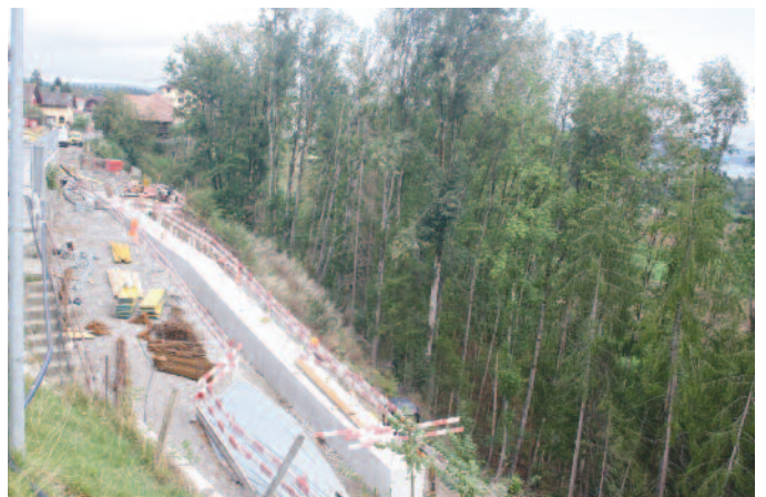
Route des Moulins vers l'ancienne laiterie. Etat du chantier à la jonction de la route du Larret et de la route des Moulins.
