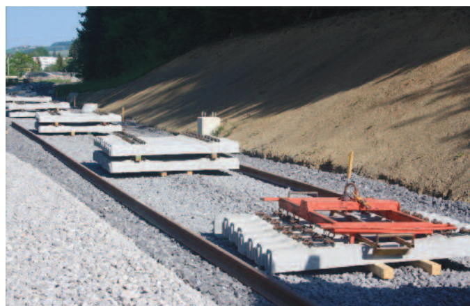
Pra-Bosson. Traverses et rails prêts pour la mise en place.
