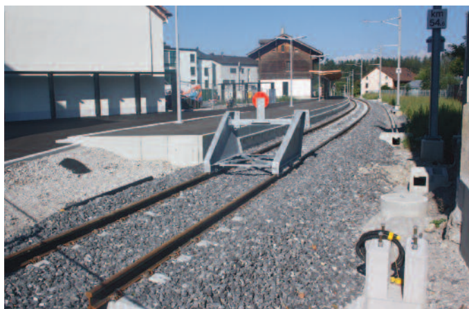
Gare de Broc-Village. La nouvelle voie s'arrête provisoirement ici.
