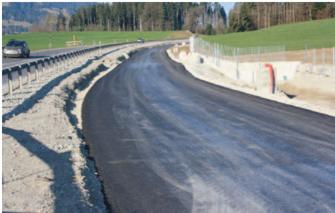
Etat des travaux à la descente de Pra-Riond vue en direction de La Tour-de-Trême.
