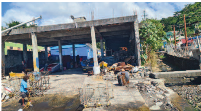
L'atelier de réparation à la Dominique.
