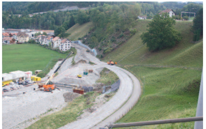
Route des Moulins. Le passage sous-voie est en construction.
