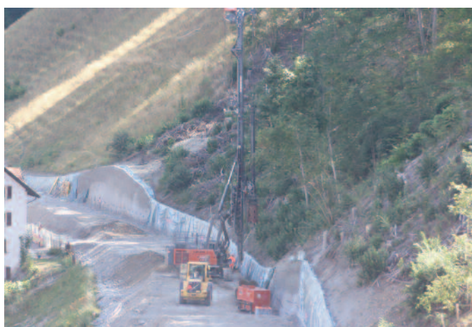
Broc-Fabrique. Le mur de soutènement prend forme.
