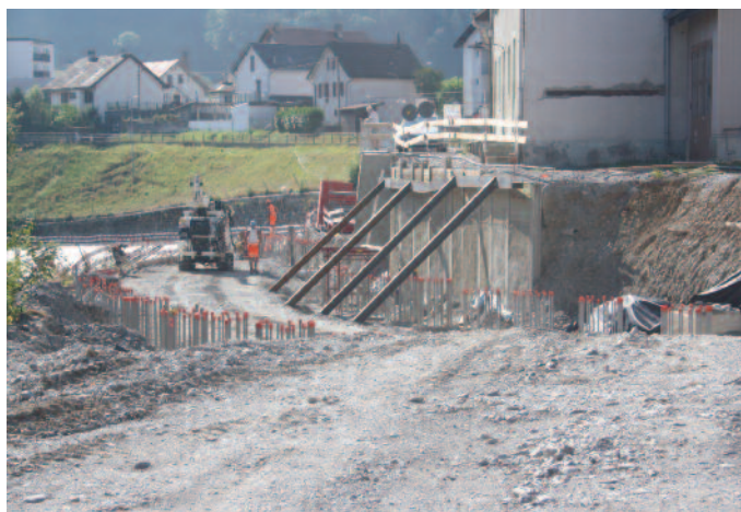
Route des Moulins. Ancien PN de la laiterie. Etat des travaux au début de la descente vers Broc-Fabrique.
