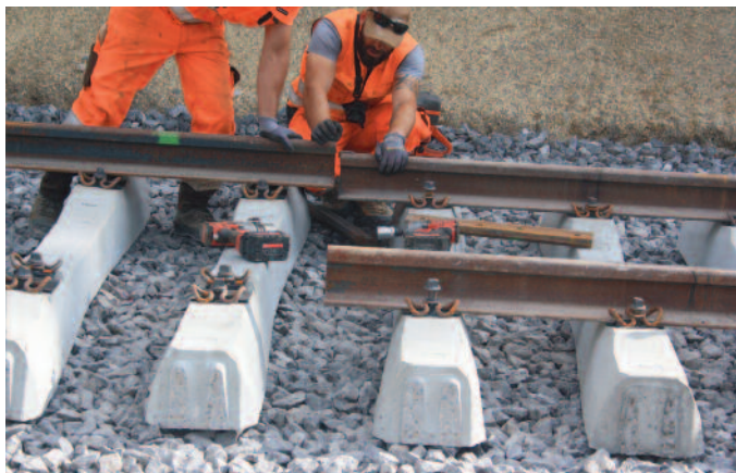
Pra-Bosson. On procède aux raccordements des rails.
