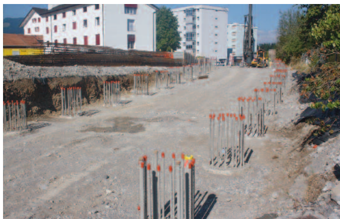
Rte des Moulins. Ancien PN de la laiterie. Etat des travaux en direction de Broc-Village.
