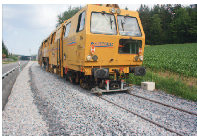
Pra-Bosson. Bourreuse en action sur le tronçon Pra-Riond - Les Marches.
