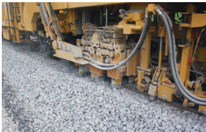
Pra-Bosson. Boulonneuse en action sur le tronçon Pra-Riond - Les Marches.
