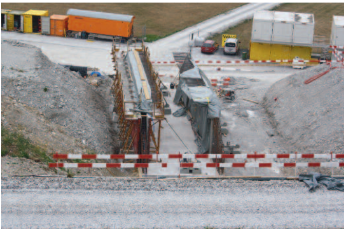
Broc-Fabrique, route des Moulins. Le nouveau passage sous- voie est en construction.
