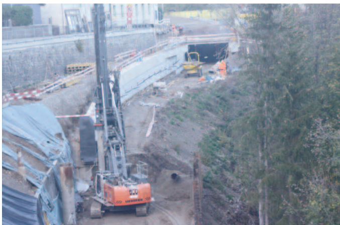
Route des Moulins. Le passage sous-route prend forme.
