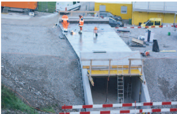
Broc-Fabrique, route des Moulins. On procède à la pose de l'isolation de la dalle du passage sous-voie.
