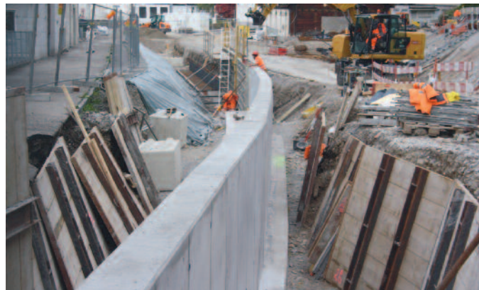
Broc-Fabrique. Construction du mur séparant la route des voies.
