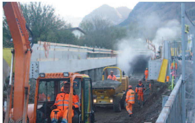
Broc-Village. Le passage sous-route vu du côté de la gare de Broc-Village.
