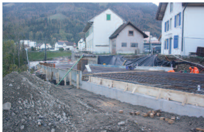
Route des Moulins. Le ferrailage du passage sous-route se poursuit.
