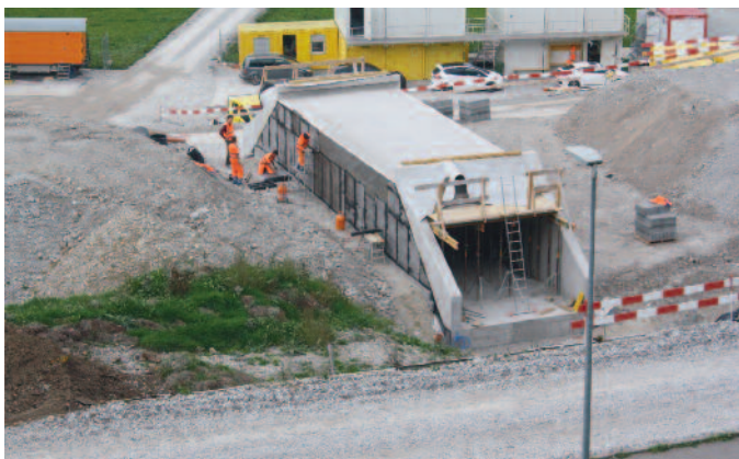
Route des Moulins. Le nouveau passage sous-voie prend forme. Les ouvriers posent l'isolation latérale.
