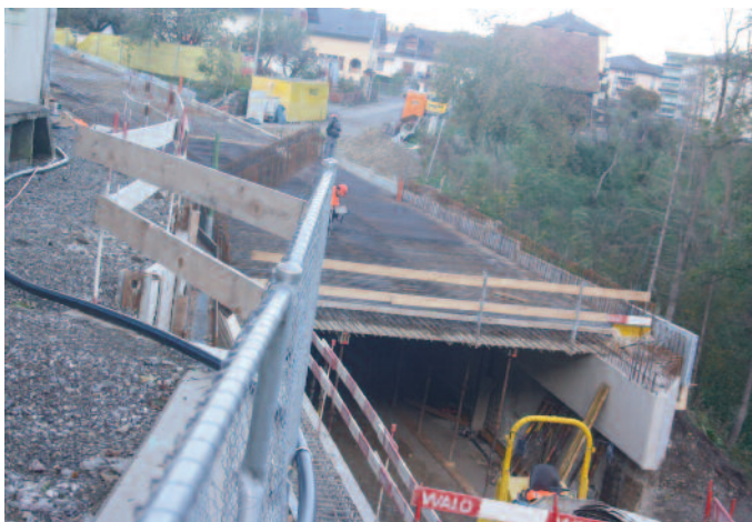
Route des Moulins. On procède au ferrailage de la dalle du passage sous-route.
