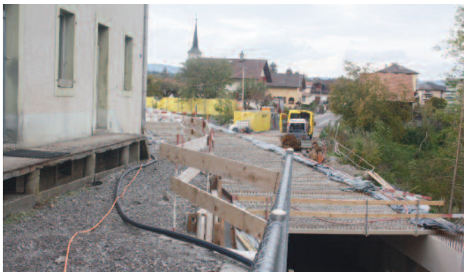
Route des Moulins. Les travaux se poursuivent tout au long du trajet. Ici l'entrée du passage sous-route à l'intersection des routes des Moulins et du Larret. On procède au ferrailage de la dalle.
