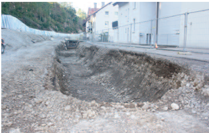
Gare de Broc-Fabrique. Impressionnantes fouilles.
