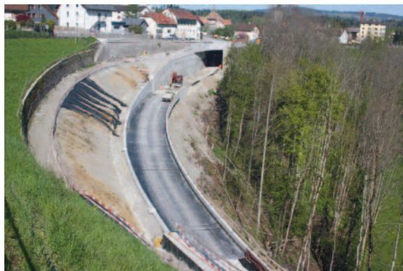
On distingue bien la sortie du nouveau tunnel et la plate-forme qu’il a fallu soutenir par des piliers implantés dans le sol. (Photo : Edouard Grandjean)
